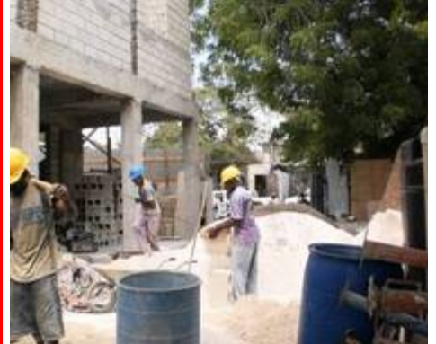
Chantier des nouveaux édifices
