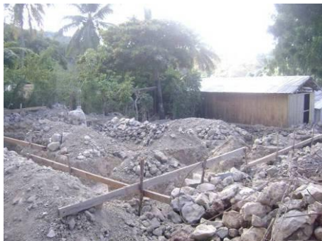
Vue des fouilles des fondations
