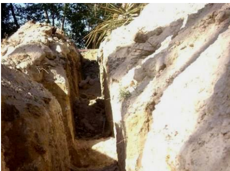
Vue des fouilles des fondations
