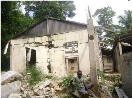
Démolition des bâtiments affectés
