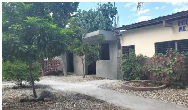
Le bâtiment actuel et l'extension construite pour abriter le laboratoire informatique
